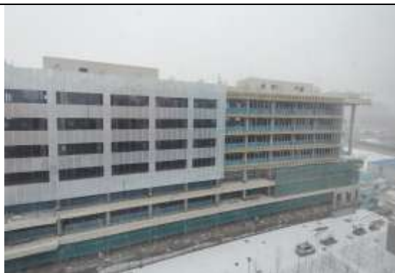
项目北侧-在建科研楼
