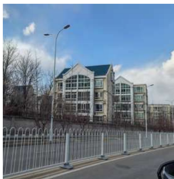
项目西侧-海德堡小区
